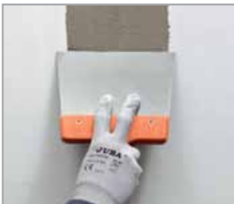
5. Rellenar juntas entre placas
