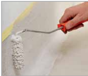
1. Colocación del zócalo
