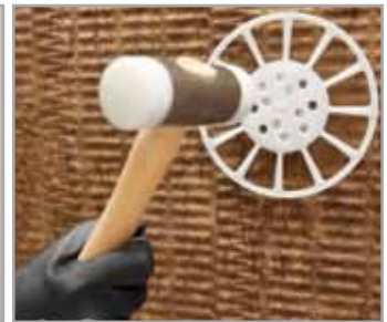
4. Fijación mecánica de las placas
