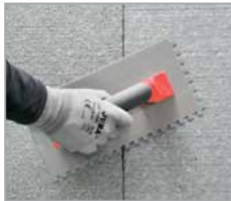
3. Colocación del material aislante
