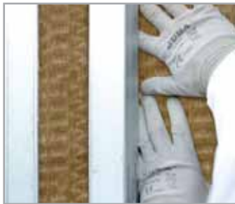
2. Colocación del material aislante
