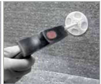
4. Fijación mecánica de las placas
