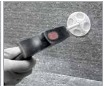
4. Fijación mecánica de las placas
