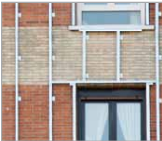
1. Colocación de la estructura metálica
