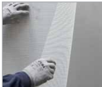
6. Enlucido armado de los paneles
