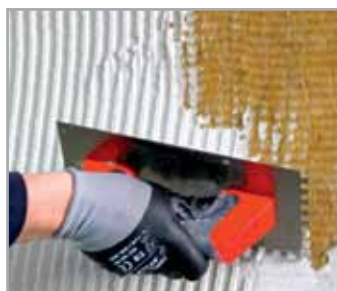
6. Armado con la malla
