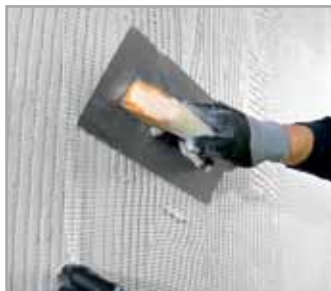
7. Enlucido armado de los paneles
