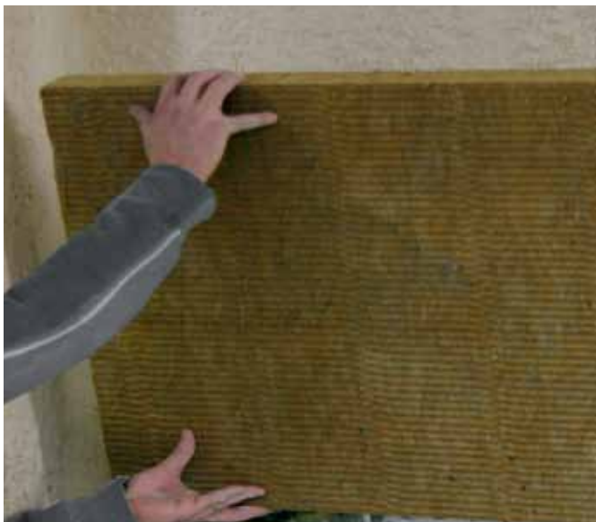
3. Colocación del panel aislante en el perfil de arranque
