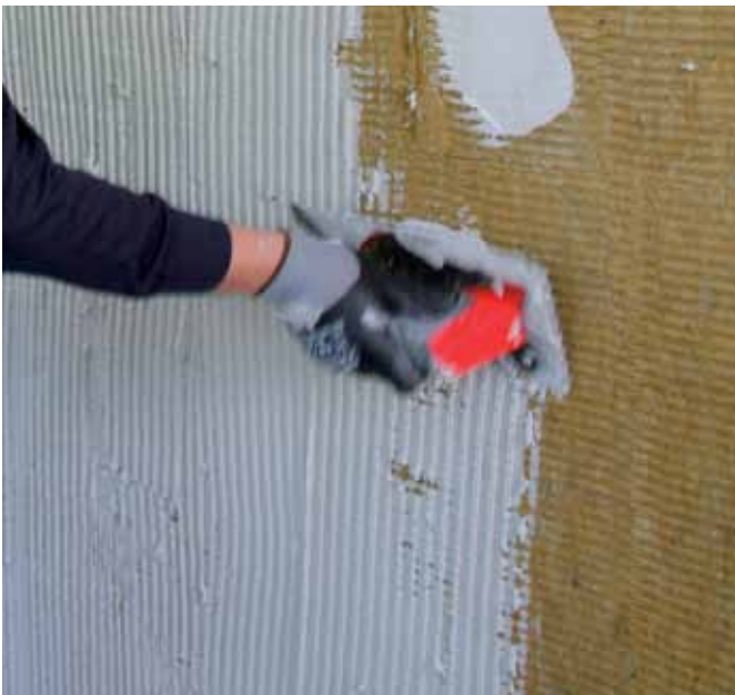
6. Enlucido de la lana de roca con el Mortero Base ligero BME 12007
