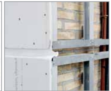
4. Colocación de las placas
