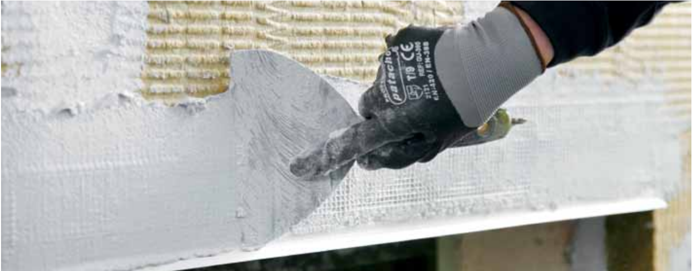
5. Colocación del perfil horizontal en ventana
