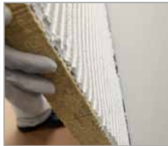
3. Colocación del material aislante
