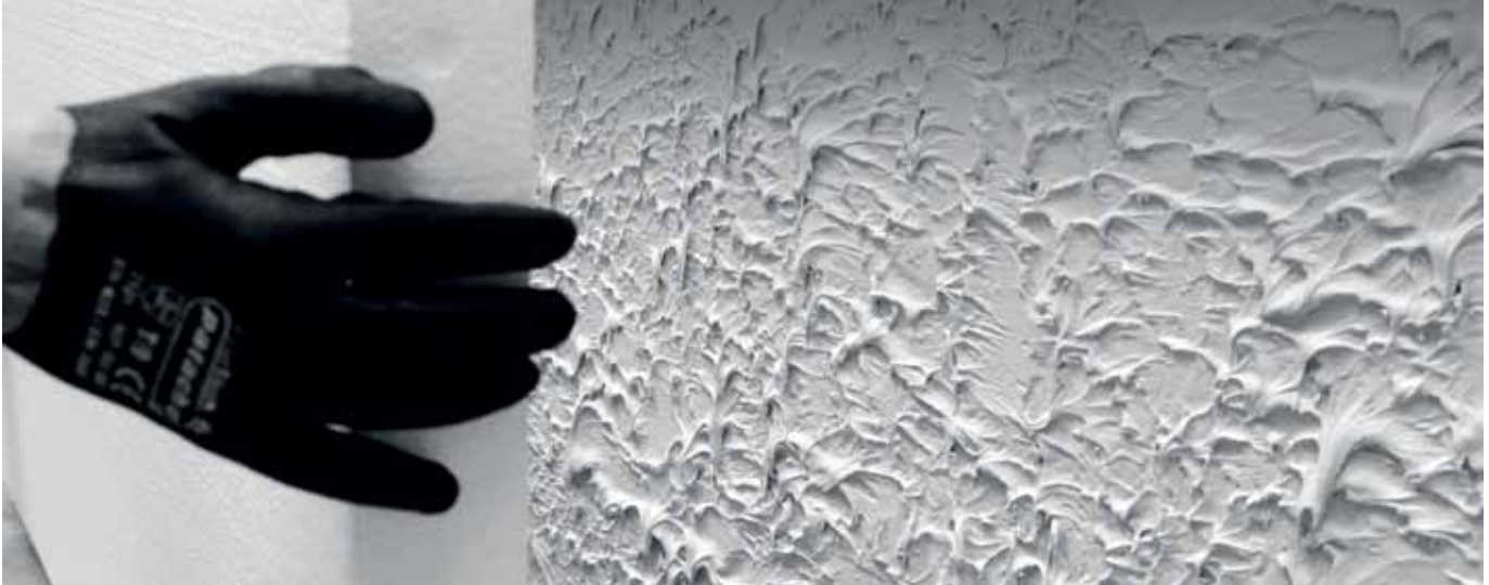
1. Colocación del zócalo sobre el Mortero Impermeabilizador BME 18002
