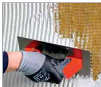
6. Armado con la malla
