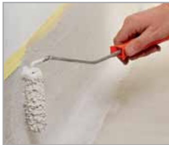
1. Colocación del zócalo
