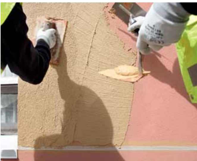
8. Aplicación y Fratasado del Revestimiento decorativo Granocryl BRS SL15
