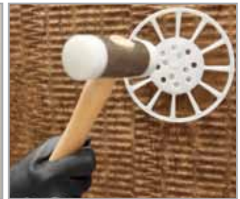
4. Fijación mecánica de las placas
