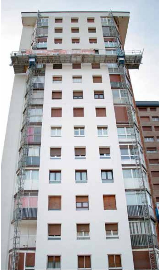
7. Fachada enlucida con el mortero Revoco placas BMB 12012
