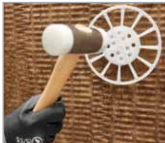
3. Fijación mecánica de las placas
