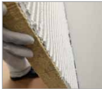
3. Colocación del material aislante
