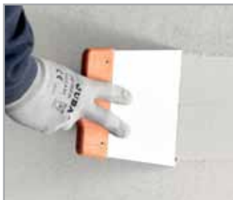
5. Rellenar juntas entre placas
