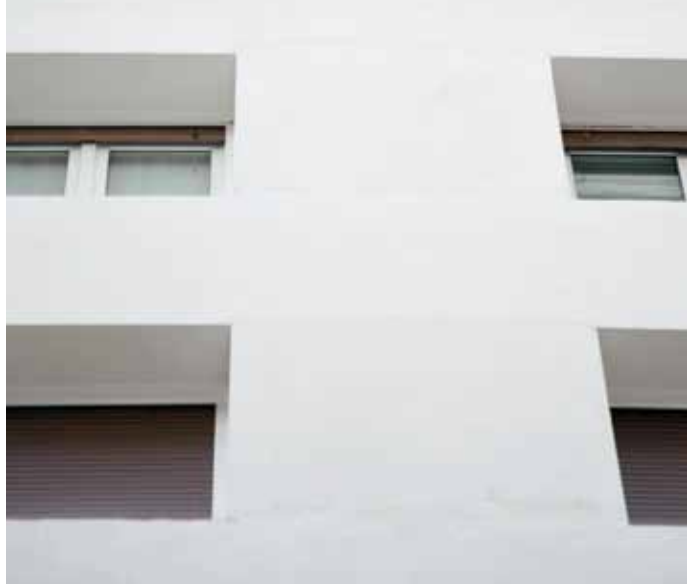
7. Fachada enlucida con el mortero Revoco placas BMB 12012
