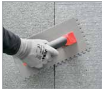
3. Colocación del material aislante
