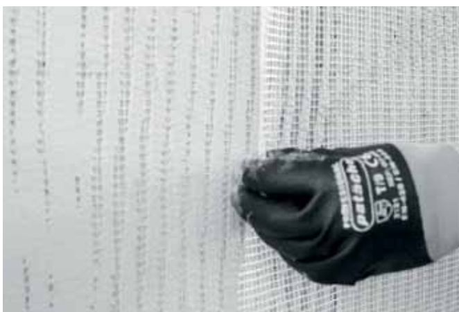
6. Embutido de la malla en el mortero
