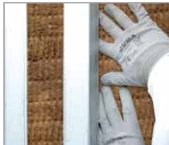
2. Colocación del material aislante
