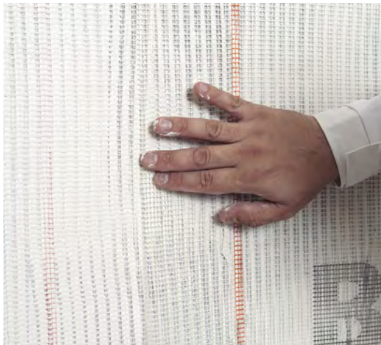
La malla debe ir colocada a testa.
