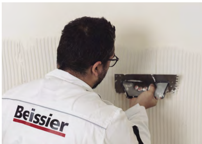
El revoco debe aplicarse con llana dentada de 8 mm.
