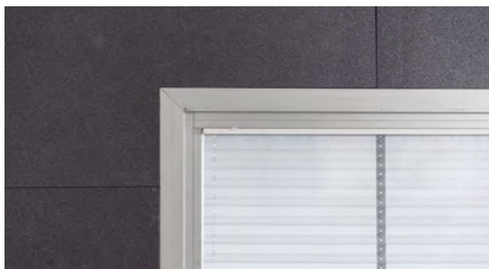
Las placas deben colocarse al tresbolillo y en bandera en los huecos de puertas y ventanas.
