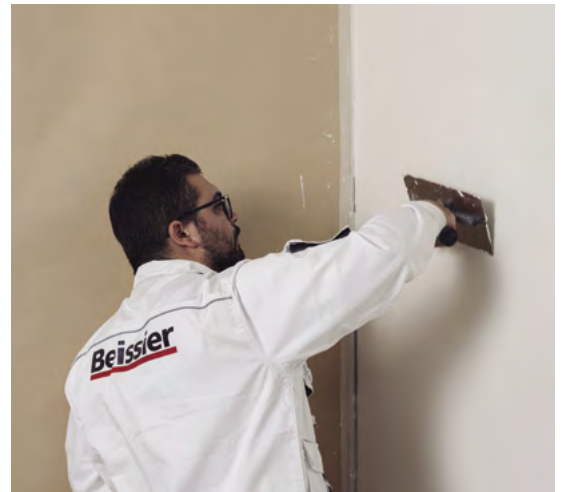
Finalizar con una capa de regularización con el mismo Revoco Fino Interior BMB12002.
