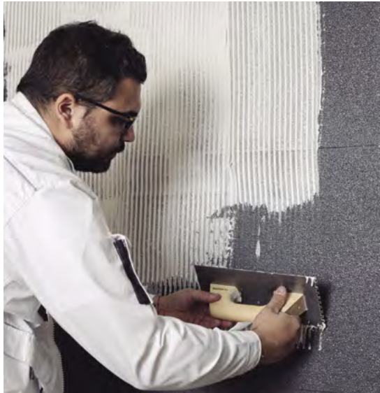
Aplicar el Revoco Fino Interior con llana dentada de 6mm.
