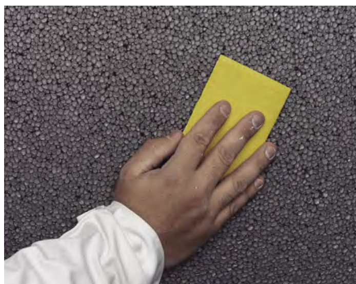
Los desniveles en las placas pueden corregirse mediante un lijado suave.
