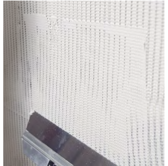
Embutir la malla en el tercio exterior del Revoco Fino Interior BMB 12002.
