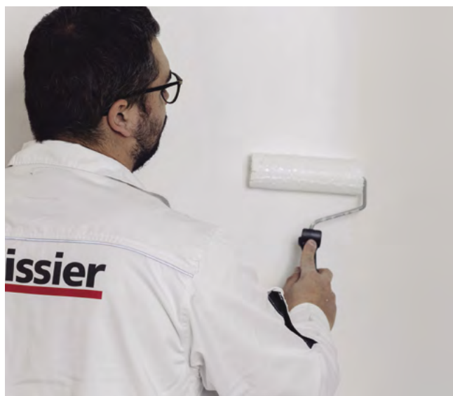
Acabado con Beta Therm In, que complementa el sistema gracias a sus propiedades termoaislantes.
