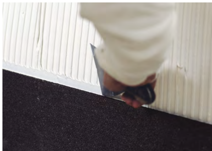
El revoco no debe en ningún caso rebasar los bordes del panel.
