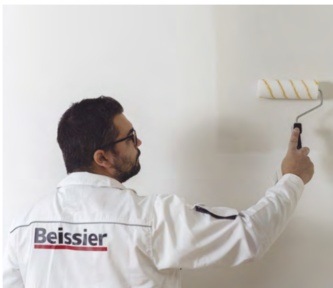
Imprimación previa al pintado.
