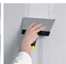
RELLENO / ENCHIMENTO DE JUNTAS
