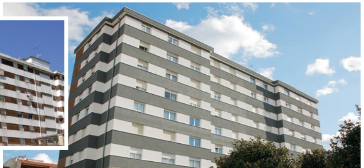
Rehabilitado con sistema Granocryl
