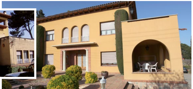
Rehabilitado con sistema Granocryl
