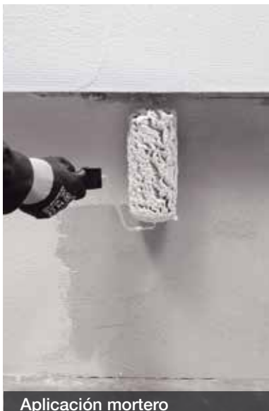
Aplicar mortero como adhesivo
