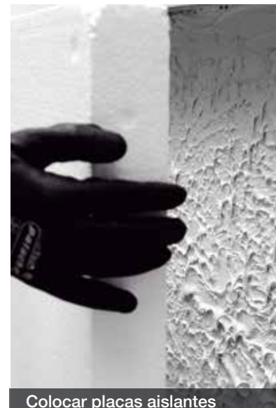
Aplicar mortero como adhesivo
