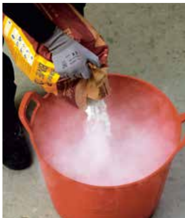
Añadir agua y mortero
