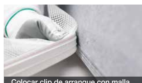
Colocar clip de arranque con malla
