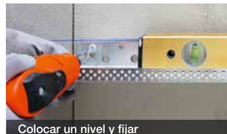
Realizar primer anclaje
