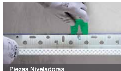
Colocar un nivel y fijar
