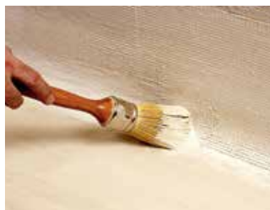
Aplicación del mortero
