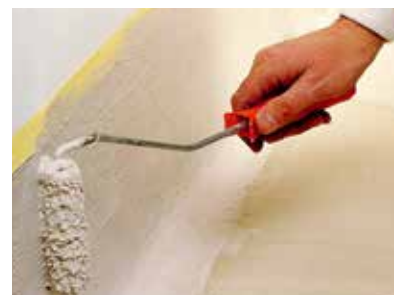
Aplicación del mortero
