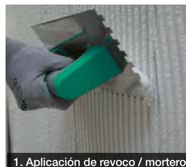
1. Aplicación de revoco / mortero
