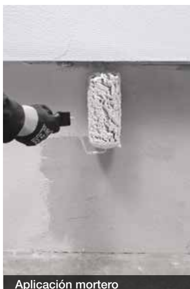
Aplicar mortero como adhesivo
