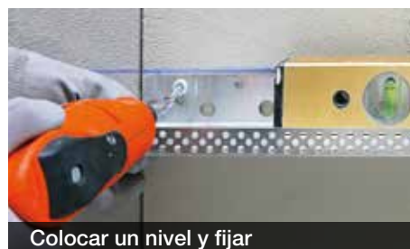
Colocar un nivel y fijar
