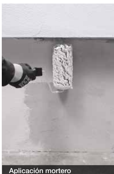
Aplicar mortero como adhesivo
