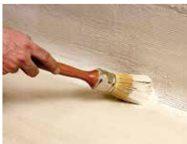
Aplicación del mortero
