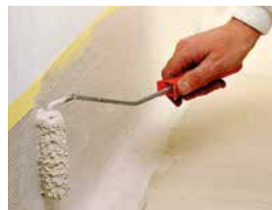
Aplicación del mortero
