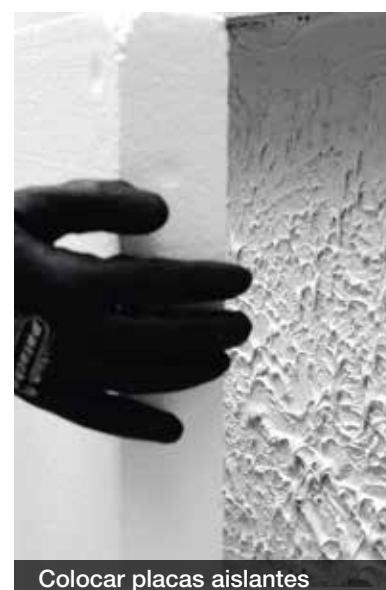
Aplicar mortero como adhesivo
