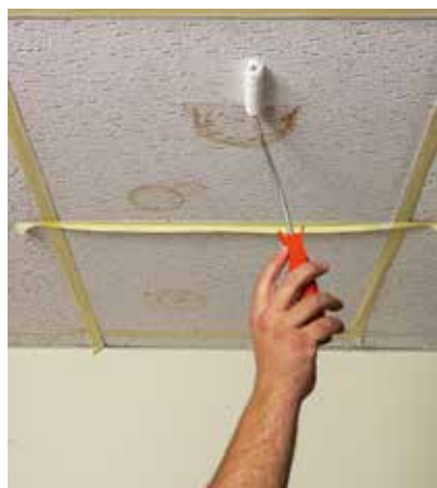
2. Producto listo al uso. Aplicar a brocha o rodillo el producto sobre la mancha a aislar.
