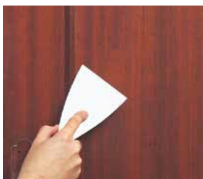
2. Amasar el tubo y aplicar directamente con el tubo o con espátula. Para grandes espesores, realizar sucesivas capas.
