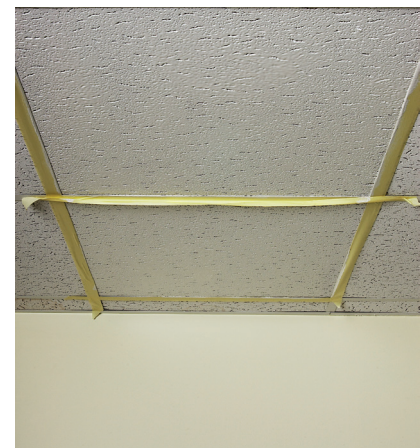
3. Esperar a que la aplicación seque por completo, aproximadamente entre 2-4 h, para un repintado con pinturas al agua.
