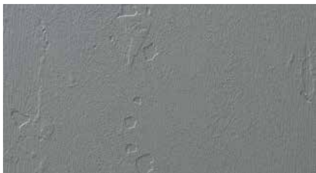
1. Pared con pintura plástica.
