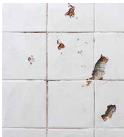
1. Eliminar los azulejos sueltos o rotos.
