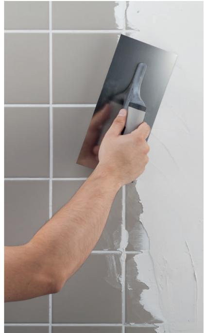
Aplicada una primera capa de cualquiera de los tres productos que haya sido seleccionado, procederemos a colocar una malla de fibra de vidrio de 80gr/m<sup>2</sup> cubriendo la totalidad de superficie a tratar. Ésta se embutirá en el tercio medio de la capa del plaste y las uniones deben solaparse 10cm.
