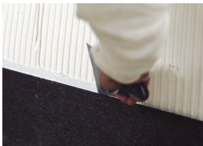
O reboco não deverá em caso algum passar as bordas do painel.
