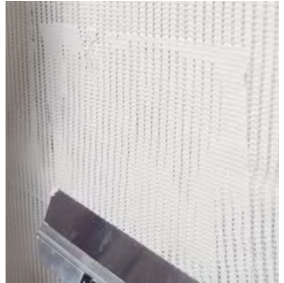
Embutir a malha no terço exterior do Reboco Fino Interior BMB 12002.
