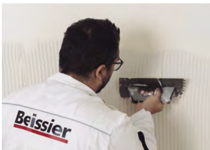
O reboco deve ser aplicado com talocha dentada de 8 mm.
