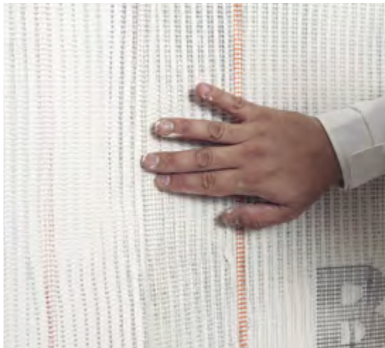
A malha deverá ser colocada no final.
