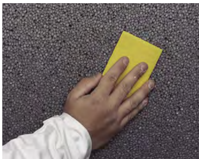
Os desníveis nas placas podem ser corrigidos através de um polimento suave.
