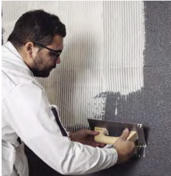
Aplicar o Reboco Fino Interior com talocha dentada de 6 mm.
