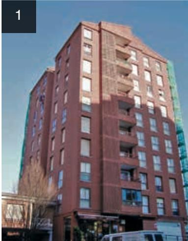
1. Edificio antiguo revestido con pintura antigoteras. Presenta microfisuras generalizadas en el revestimiento así como descomposiciones abundantes de la arcilla del ladrillo cara vista.
