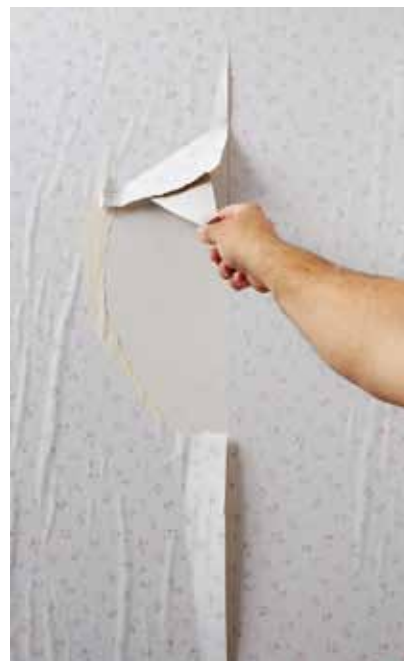
3. Repetir el proceso, hasta eliminar el papel.
